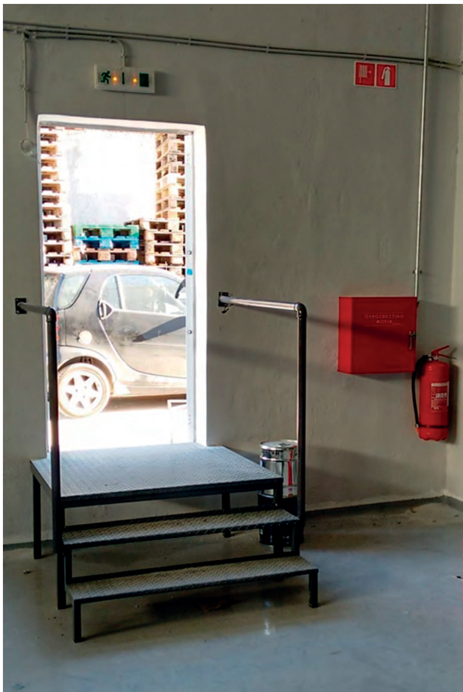
Εγκατάσταση πυροσβεστήρα πλησίον σε έξοδο κινδύνου.
